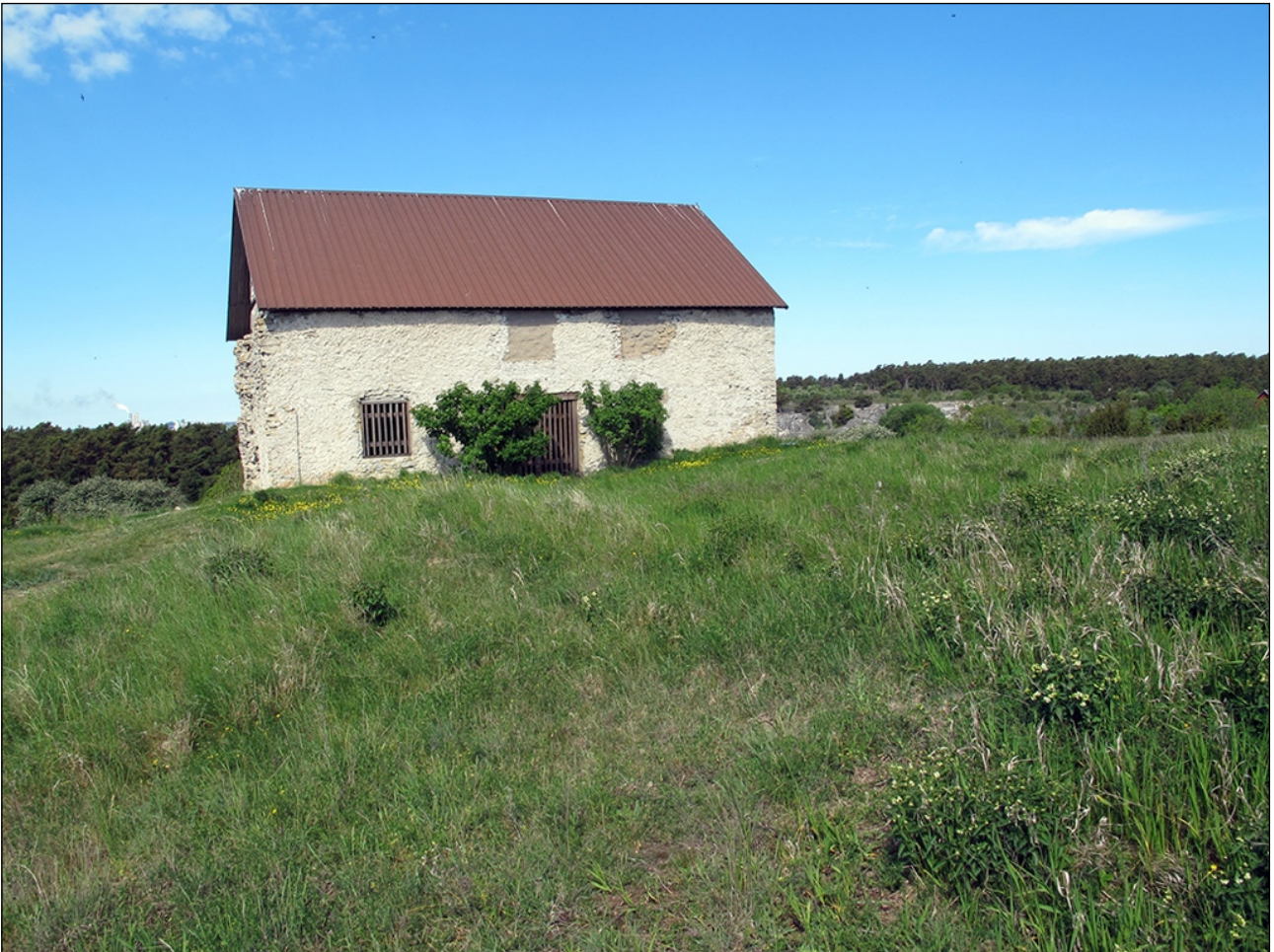
Figur 5. Den stående byggnaden sedd från öster med ruinen av kyrkan i förgrunden, kraftigt över med högt gräs. Murarna är relativt oprecisa och starkt raserade. Endast i det nordöstra hörnet kan man skymta en tydlig mur, i övrigt är ruinen helt dold i vegetationen, vilket gör det svårt som besökare att uppfatta anläggningens omfattning och utbredning.
