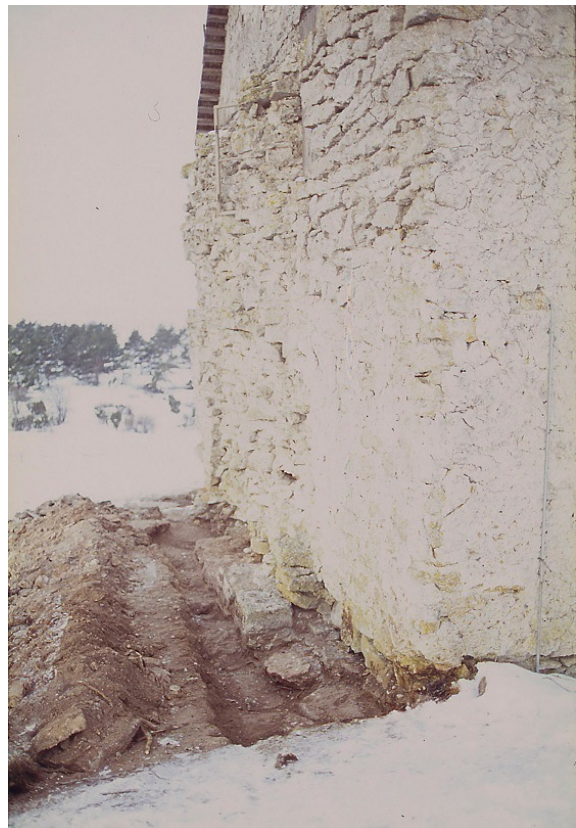
Fig. 5. Diabild som visar schaktet intill magasinet (1976).
